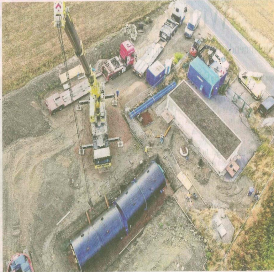
Mit Fertigstellung eines Zwischenbehälters am Goldborn – hier ein Bild vom Bau – kann ab 13. Dezember vier Grad weiches Fernwasser geliefert werden.
