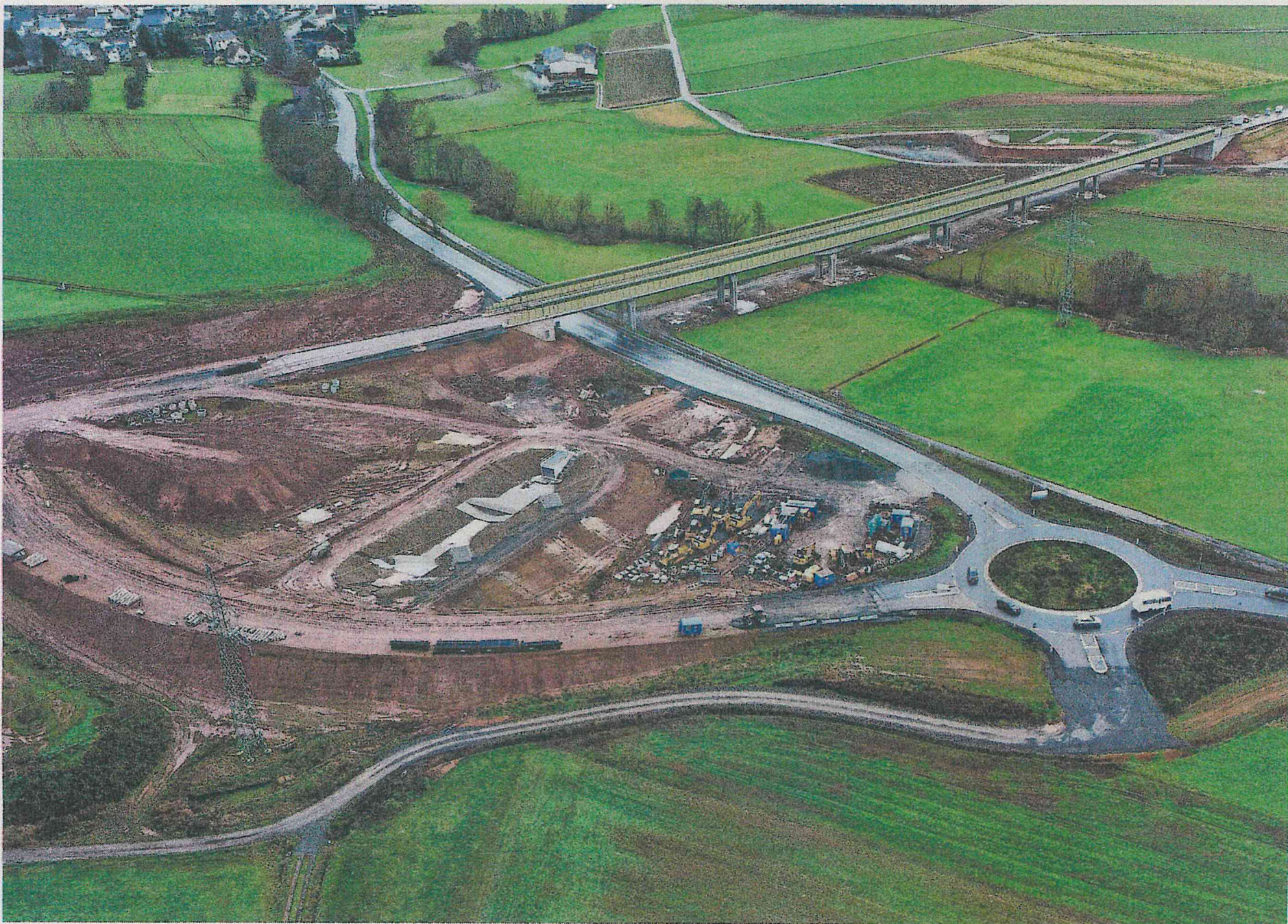
Die B-252-Ortsumgehung MüWeLa ist am Werden. Die Luftaufnahme zeigt die Wollmortalbrücke die über die B 236 führt und den neuen Anschluss-Kreisel. FOTO: NADINE WEIGEL
