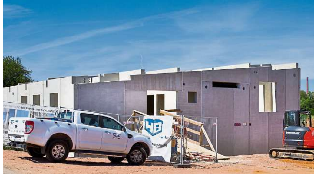
Der Rohbau der Umkehrosmoseanlage ist noch nicht ganz fertiggestellt. An den verschiedenen großen Öffnungen für die Leitungen, auf die Björn Mattheß zeigt (ganz oben), kann man auch die Kapazitäten der einzelnen Quellen erkennen. Fotos: Ulrike Bernauer
